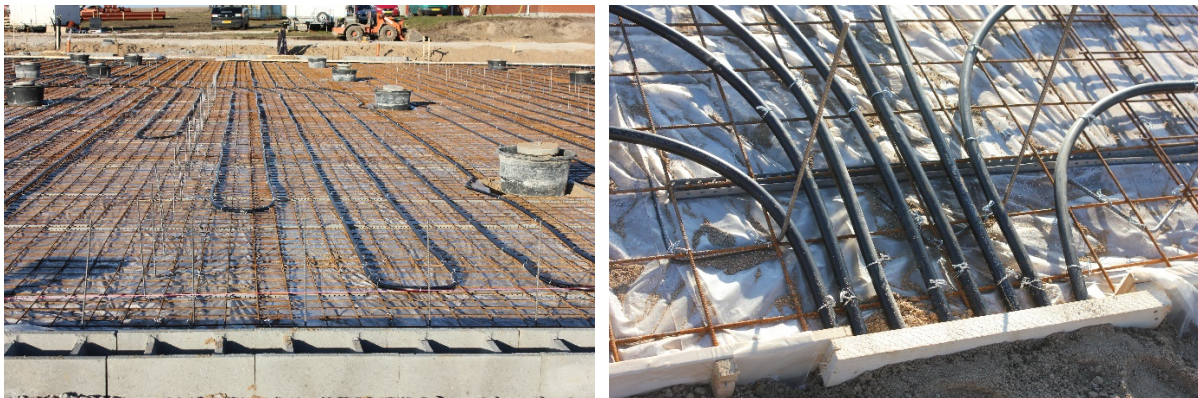
Figur 6. Eksempel på udlægning af varmeslanger i forbindelse med etablering af gulv i farestalden
